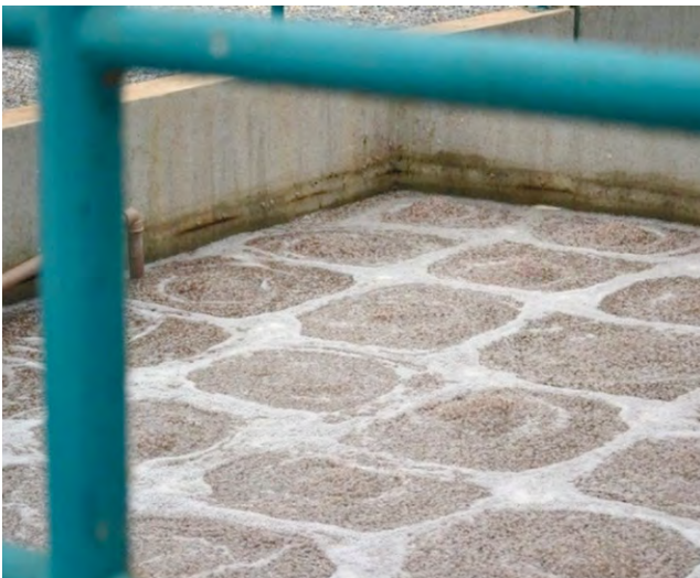
Fotos 3 e 4. Tanques para alevingem em Sistema 100% RAS, água clara, com Biofiltro e mídias MBBR para nitrificação.– alta produtividade e máxima biosseguridade. RAS Genomar, Guapé/MG., 2026.
