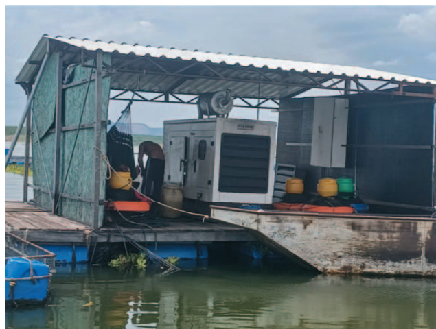
Foto 10. Implantação de aeradores tipo Chafariz, alimentados por gerador a diesel.
