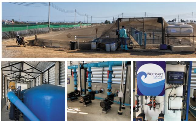
**Figura 15.** Acima. Viveiro intensivo. Abaixo. Filtros pressurizados à esquerda, bombas com dosadores de cloro e gerador de ozônio, na fazenda parceira da CPF na província de Phetchaburi.
