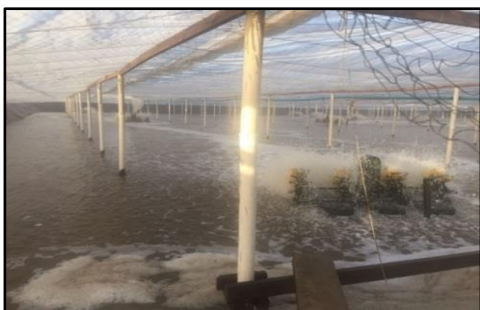
Foto 92 – Viveiros com estruturas de coberturas em madeira e colunas em PVC- Fonte: ABCC.
