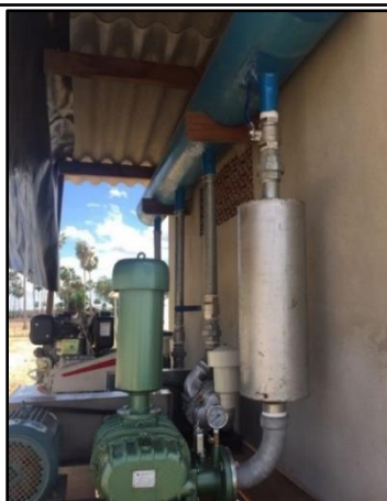
Fotos 103 a 104 – Sopradores e compressores para distribuição de ar em mangueiras microporosas de baixa pressão em viveiros intensivos Fonte: ABCC - 2020.
