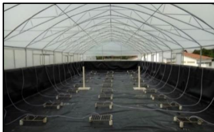
Foto 101 – Distribuição de aeração vertical com mangueiras microporosas de baixa pressão “em viveiros intensivos” Fonte: MCR Aquacultura - 2017.
