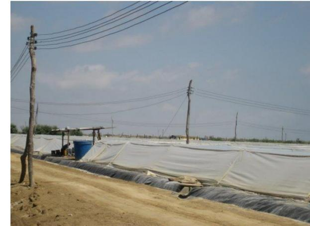
Los invernaderos y su estructura pasaron de ser de modelos a 2 aguas con pendiente pronunciada o modelos totalmente planos ambos sistemas con soportes de bamboo o tubos de acero a un modelo mixto (con caída suave a 2 aguas) y con postes de pvc rellenos de concreto.
