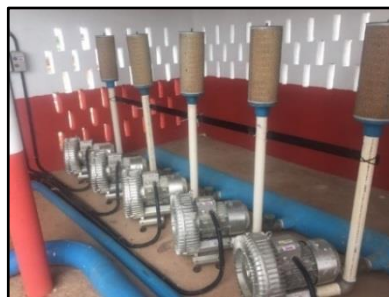
Fotos 109 a 111 – Sopradores e compressores para distribuição de ar em mangueiras microporosas de baixa pressão em viveiros intensivos Fonte: ABCC - 2020.
