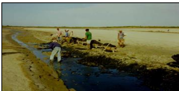
Fotos 70 e 71 – Limpeza do viveiro para remoção de resíduos contaminados Fonte: MCR Aquacultura Ltda. - 2003.
