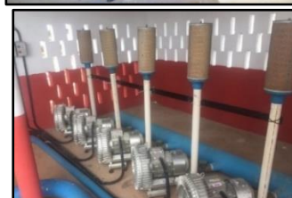
Fotos 103 a 104 – Sopradores e compressores para distribuição de ar em mangueiras microporosas de baixa pressão em viveiros intensivos Fonte: ABCC - 2020.
