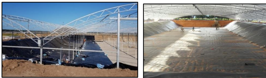
Fotos 93 e 94 – Aplicação de geomembrana em PEAD - Fonte: ABCC.
