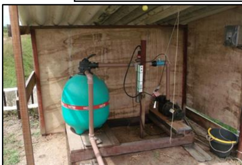
Figura 07 – Esquema ilustrativo de tratamento de água com filtro de areia- Fonte: ABCC.
