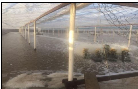
Foto 92 – Viveiros com estruturas de coberturas em madeira e colunas em PVC- Fonte: ABCC.
