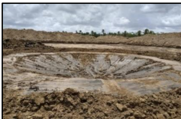
Foto 95 – Construção de um dreno central do tipo “toilets”- Fonte: MCR Aquacultura - 2020.
