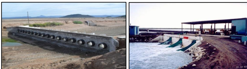
Fotos 73 e 74 – Filtração primária no canal de abastecimento de fazenda de camarão- Fonte: LIMA, Marcelo - 2006.
