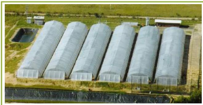
Figura 4: Bio-RAS comercial em 6 estufas (biorreatores de engorda), com um tanque de recirculação (abaixo) e tanque de concentração de lodos (denitrificador) no alto e à esquerda. Foto: Sergio Zimmermann (2004).
