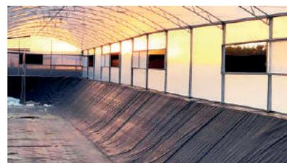
**SUPER SEAL®**, geomembrana para revestimentos de tanques e reservatórios. Possui excelente desempenho e é amplamente utilizada como barreira impermeabilizante.
