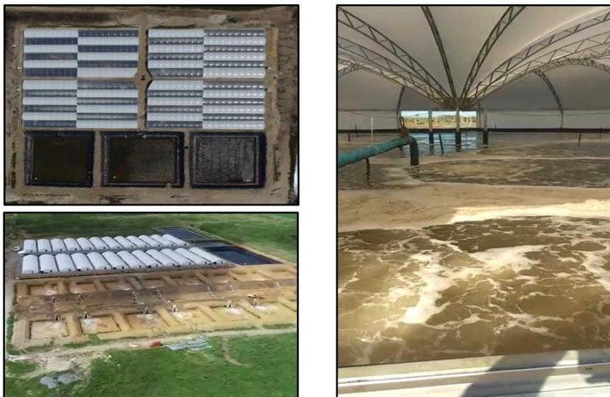
Fotos 92 a 94 – Viveiros intensivos quadrados, retangulares e circular. Estruturas de coberturas em metal e madeira
