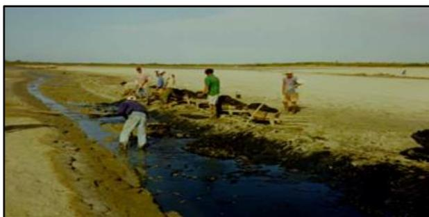
Fotos 70 e 71 – Limpeza do viveiro para remoção de resíduos contaminados
