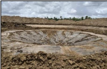
**Foto 101 – Construção de um dreno central do tipo “toilets”**
