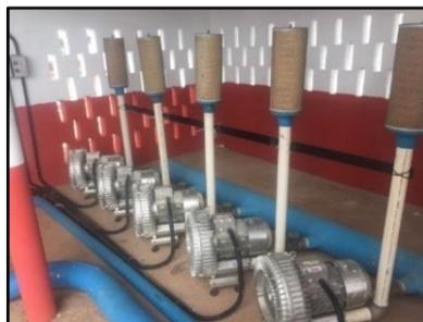
Fotos 109 a 111 – Sopradores e compressores para distribuição de ar em mangueiras microporosas de baixa pressão em viveiros intensivos
