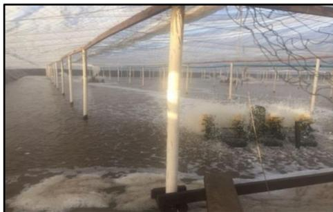
**Foto 95 – Viveiros com estruturas de coberturas em madeira e colunas em PVC**
