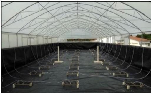
Foto 107 – Distribuição de aeração vertical com mangueiras microporosas de baixa pressão “em viveiros intensivos”
