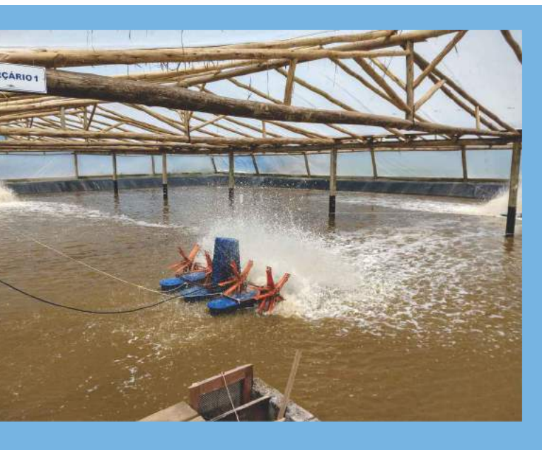
Figura 1. Berçário intensivo da empresa Mar do Brasil Aquicultura . São seis berçários de 600 m 3 /cada (20 x 25 x 1,2 m), com geomembrana de 0,6 mm, estufa com filme plástico de 150 micras e aeradores de pás.
