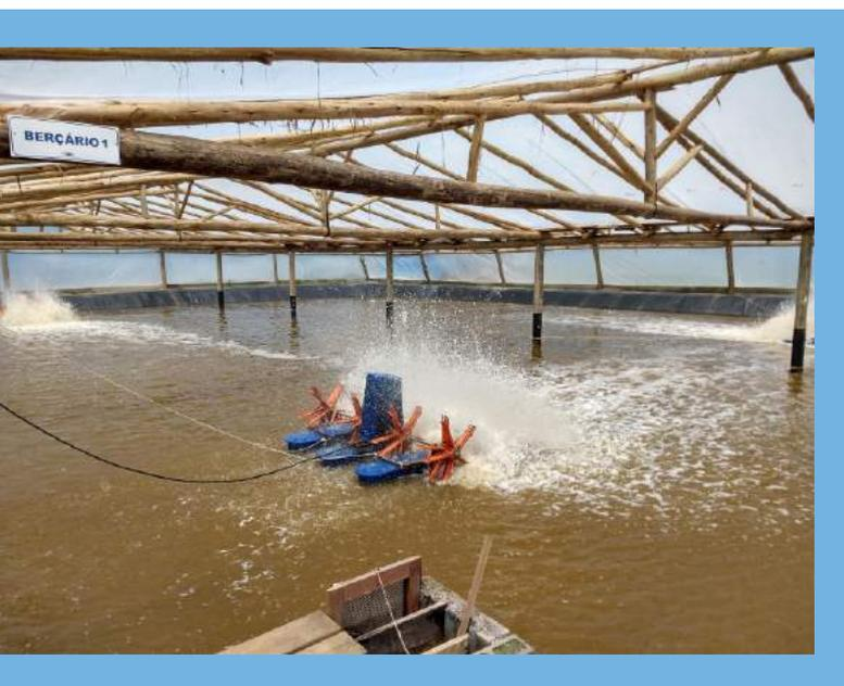
**Figura 1.** Berçário intensivo da empresa **Mar do Brasil Aquicultura**. São seis berçários de 600 m<sup>3</sup>/cada (20 x 25 x 1,2 m), com geomembrana de 0,6 mm, estufa com filme plástico de 150 micras e aeradores de pás.
