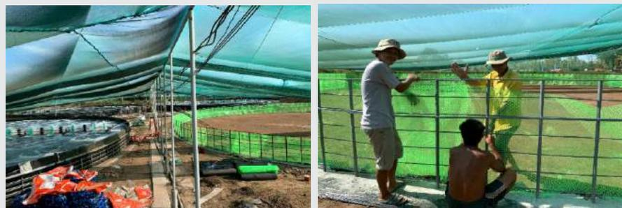
Um radier (meio-fio) de concreto fornece suporte aos postes verticais e fortaleza estrutural para um tanque circular de até 32 metros de diâmetro.
