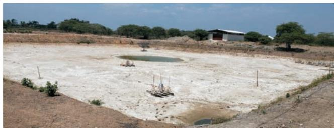
**Figura 3** – O uso de “toaletes” (centro do viveiro) para sifonar o lodo é necessário para manter o fundo do viveiro limpo. A preparação do solo requer calagem e biorremediação.
