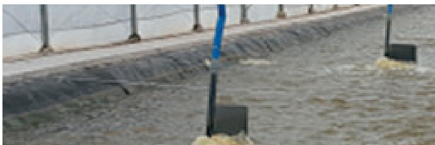
Figura 5 - Aeração na Fase 2 de produção de camarão na instalação "Biosipac".
