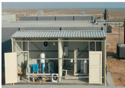
Figura 1 - Estação de tratamento de ozônio para água de captação de uma larvicultura.
