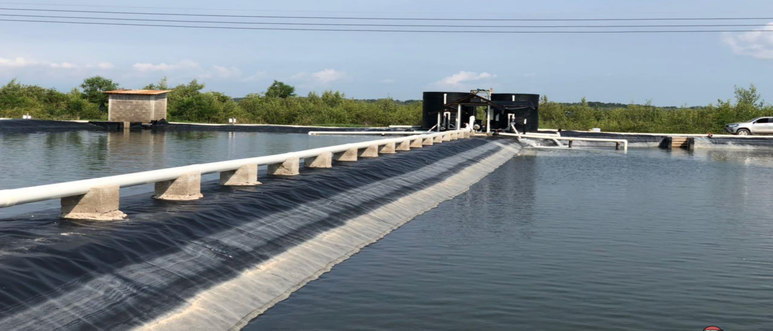
Sistema de Filtración Raceways
