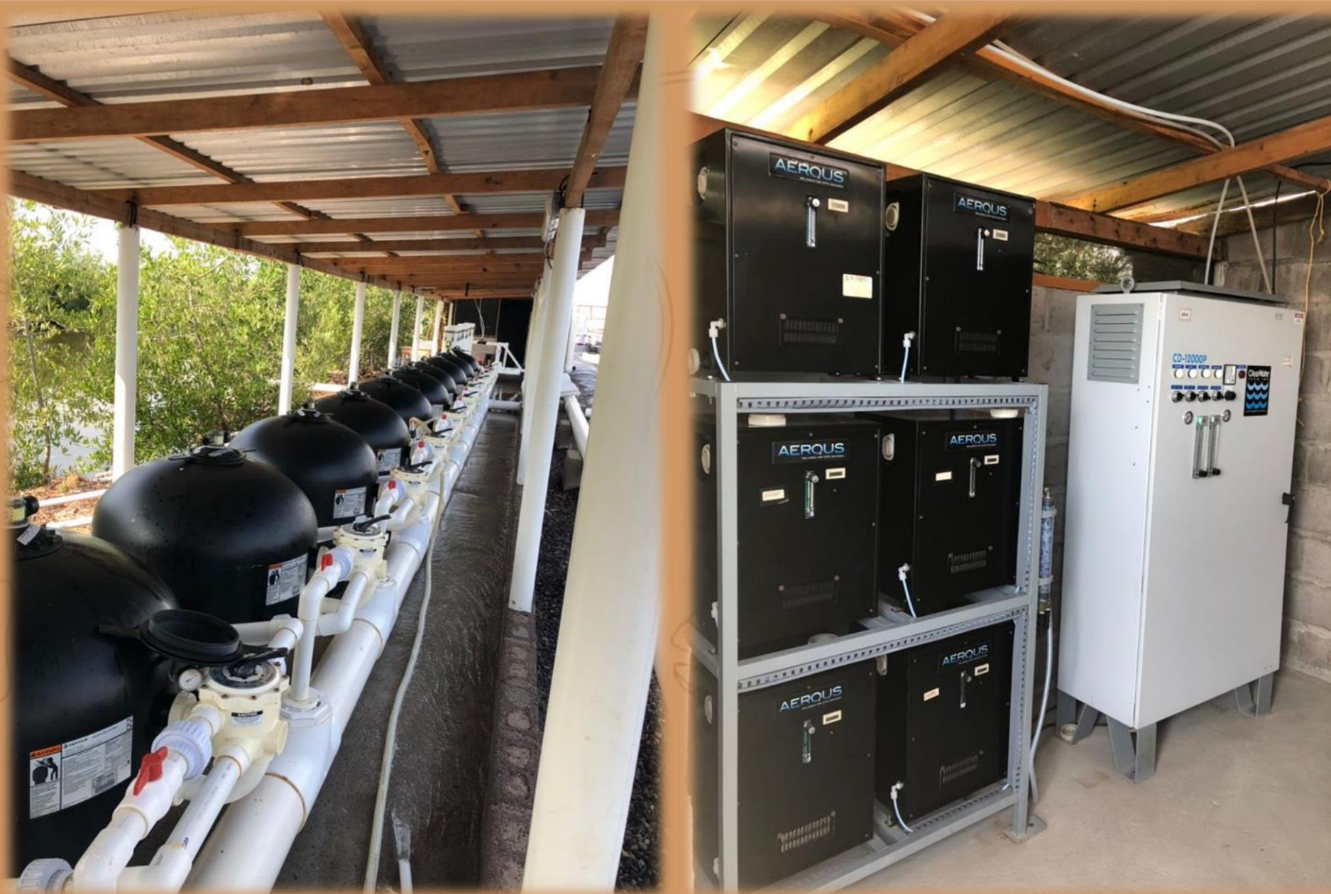
Sistema de Filtración Raceways
