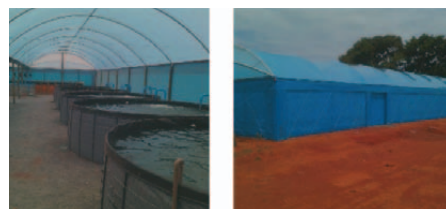
Figura 4. Estufa com SUNCOVER AV BLUE para redução de temperatura no interior do ambiente para produção de camarão.
