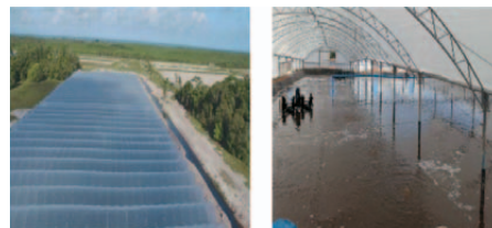
Figura 3. Estufa para produção de camarão com o filme SUNCOVER AV DIFUSO na cobertura.
