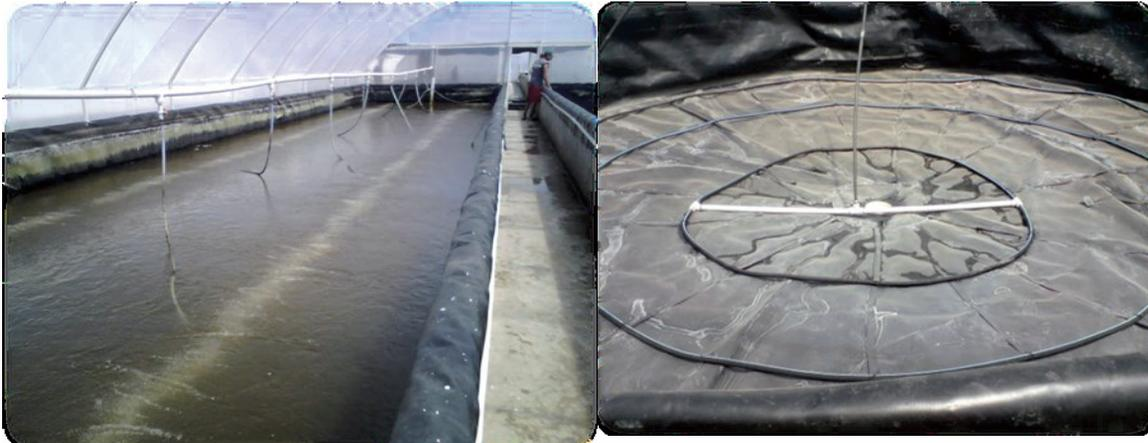
**Fotos 36 e 37:** Uso de mangueiras porosas de alta eficiência para aeração artificial de tanques berçários e *raceway*.
