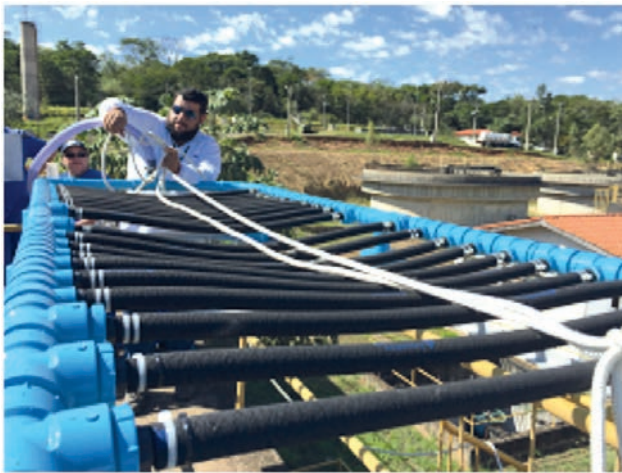
Figura 1 – Equipamento de aeração composto por mangueiras porosas: melhor relação entre consumo de energia e quantidade de oxigênio dissolvida
