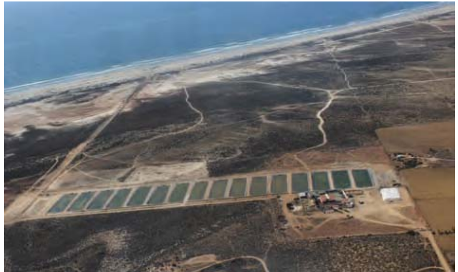
Granja con 16 estanques de producción.
