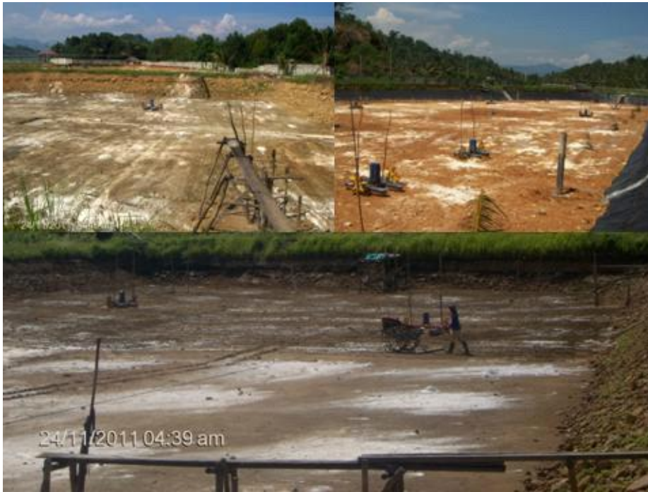
Figura 4 – Tratamento de Solo em viveiros com Liners e em viveiros semi-escavados.
