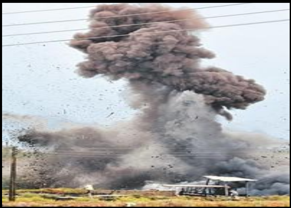
60 quilos de explosivos foram instalados em dois pontos da barragem Foto: Eduardo Maia/DN/D.A Press
