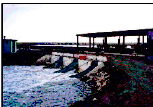
Figura 09: Exemplo de filtração de água de entrada.
