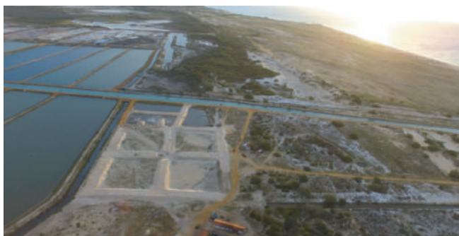
Figura 2. Vista aérea do primeiro módulo de produção superintensivo da Camarave Empreendimentos.
