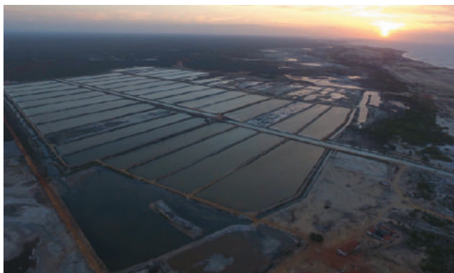
Figura 1. Vista aérea da Camarave Empreendimentos, São Bento do Norte/RN – Brasil.
