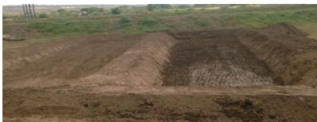
Figura 6. Escavação Raceways
