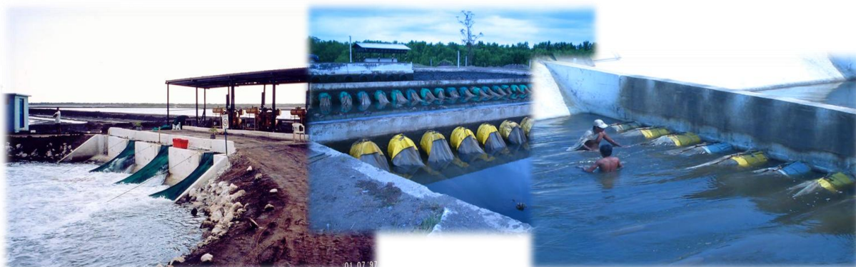
Fotos 83 a 85: Filtragem primária no canal de abastecimento de fazenda de camarão. Fonte: LIMA, Marcelo - 2006.
