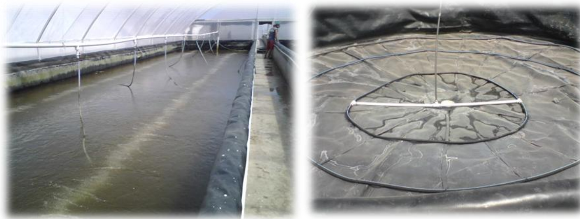
Fotos 36 e 37: Uso de mangueiras porosas de alta eficiência para aeração artificial de tanques berçários e raceway . Fonte: http://www.coloriteaerationtubing.com/aquacult_pages/aquaculture_hatcheries.htm – 2013.
