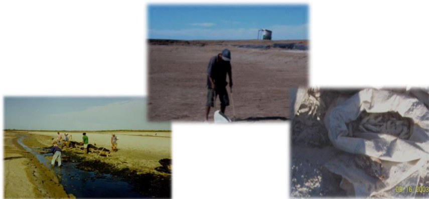
Fotos 76 a 78: Limpeza do viveiro para remoção de matéria orgânica e resíduos contaminados.
