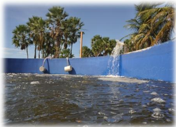
Foto 31: Tomada de água para abastecimento de berçários. Fonte: MCR Aquacultura Ltda.
